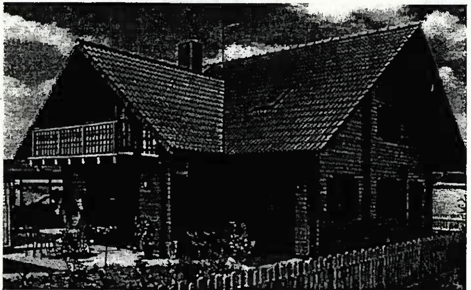
Bild 1.4-5 Wohnhaus in Blockbauweise [IFO – Wohnblockhaus]
