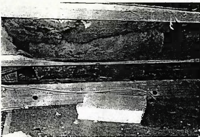
Bild 1: Fehlstellen in der Dämmung und Folie im Schwellenbereich des Daches
