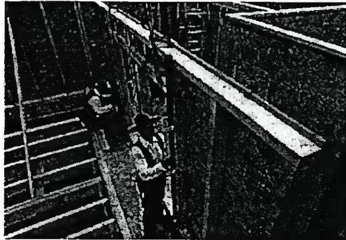
Bild 1.4-2 Aufrichten teilweise vorgefertigter Wandelemente im Holzrahmenbau (IFO - Das Holzhaus)
