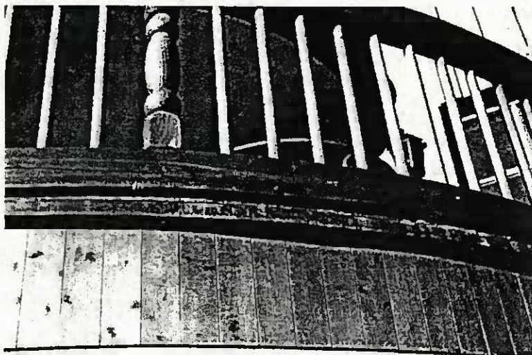
Bild 1: Ansicht des Balkons und der Risse in der Decklamelle
