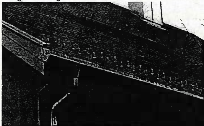
Bild 1: Verwerfung/Wölbung der Dachhaut
