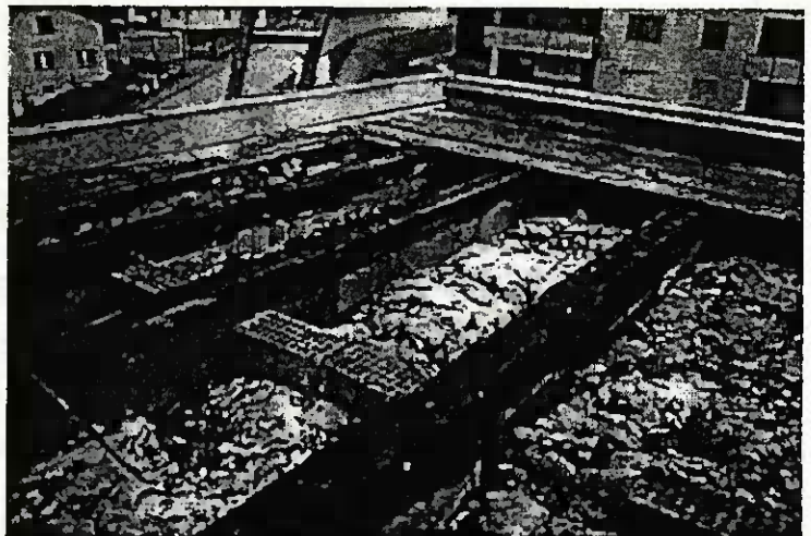
Bild 1: Befallene Balken des Flachdaches; verbildete hornartige Fruchtkörper der Lagerfäulepilze
