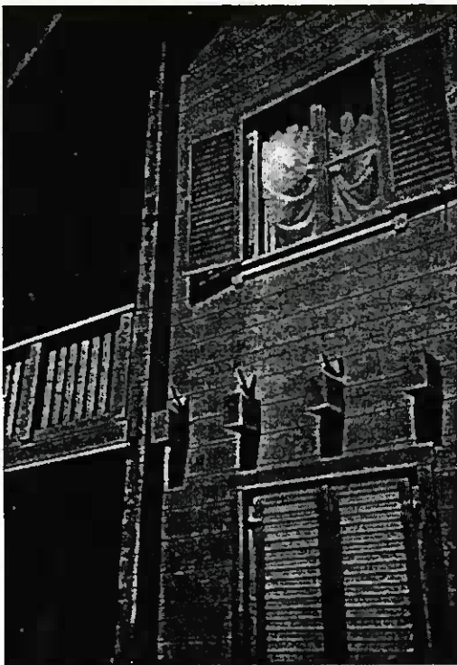
Bild 1: Südostseite des Hauses. Die Balken der Decke durchdringen die Außenwand. Dort kann Regenwasser eindringen.
