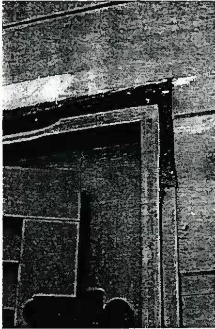
Bild 3: Obere Ecke eines Fensters Die Vorhandene Dichtungsbänder sind unzureichend.
