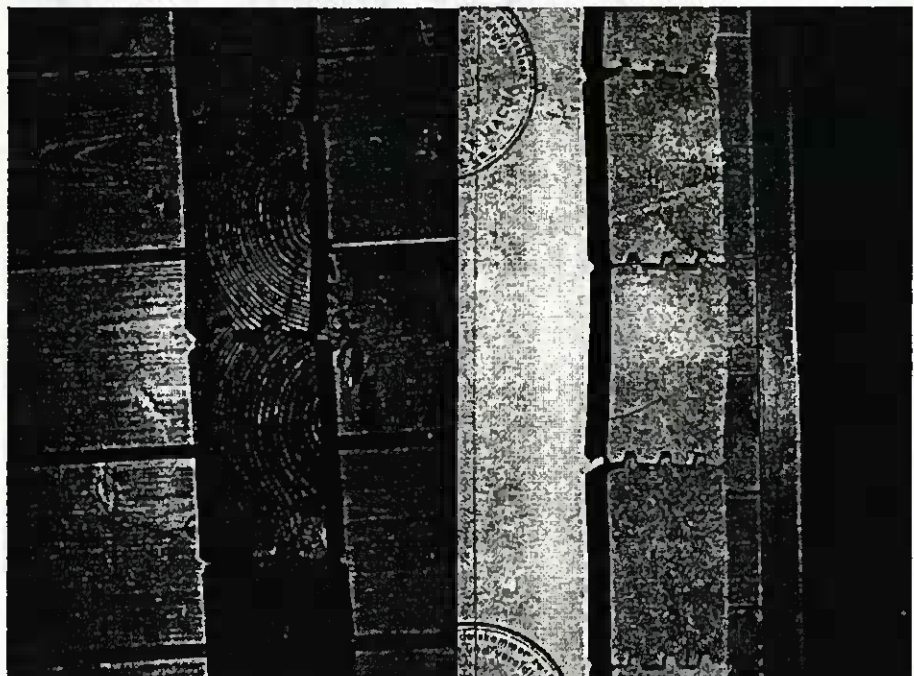
Bild 3.2-15 Fehlerhafte Ausführung: Fugenöffnungen und Ver- formungen bei Blockboh- lenwand; Blockbohlen nicht wechselseitig verlegt [Foto: Galiläa, Macha]
