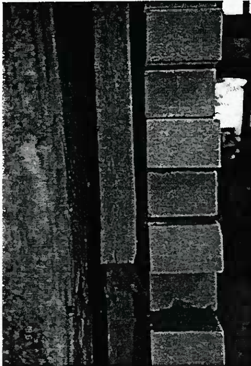
Bild 3: pendelnde Dämmung in der Luftschicht
