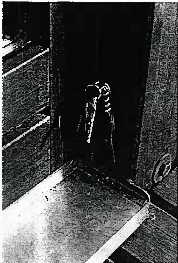
Bild 2: aufgerissene Silikonabdichtung zwischen der Alu-Sohlbank und der Holzstütze
