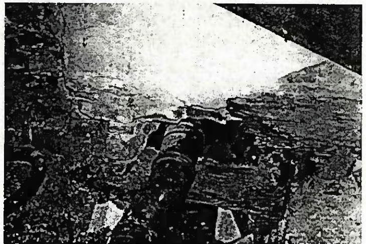
Bild 1 (oben) und 2 (unten): Verfaulte Balken mit Abflußrohr
