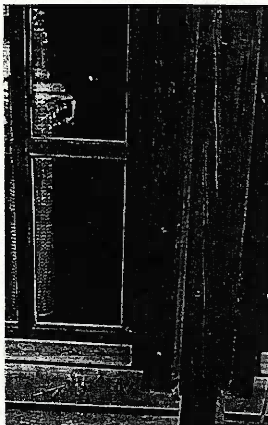
Bild 3.4-3 Nicht objektbezogene Holzauswahl: rissige Stütze zwischen zwei Fenstern, nicht fachgerechte Abdichtung [Foto: Frech]
