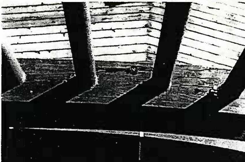
Bild 2: Typische Rißbildungen an der Oberseite des unteren Brettschichtholzbinders; Pilzbildung an der Einbindung der Stakketen
