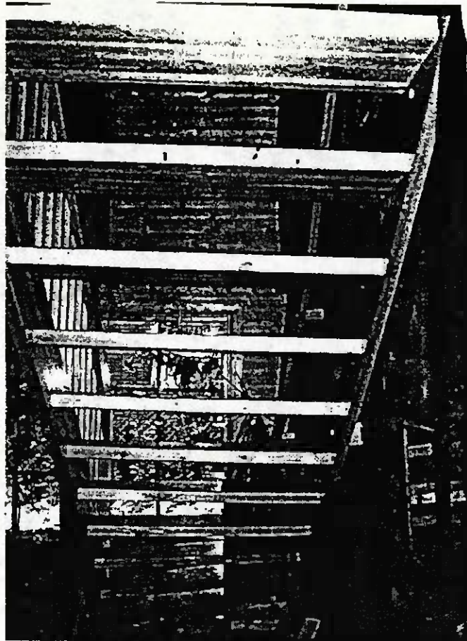
Bild 1: Unteransicht der Treppe
