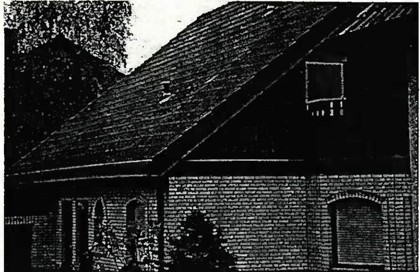
Bild 1: Knick in der Dachfläche
