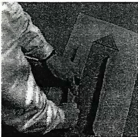
Bild 5.4-69 Luftdichte Balkendurchdringung unter Verwendung von Manschetten (Fotos: pro clima)
