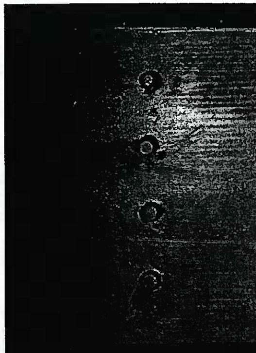
Bild 3.2-40 Nicht fachgerechter Stabdübelanschluß: ungenaue Bohrungen und unterschiedliche Stabdübeldurchmesser [Foto: Galiläa]
