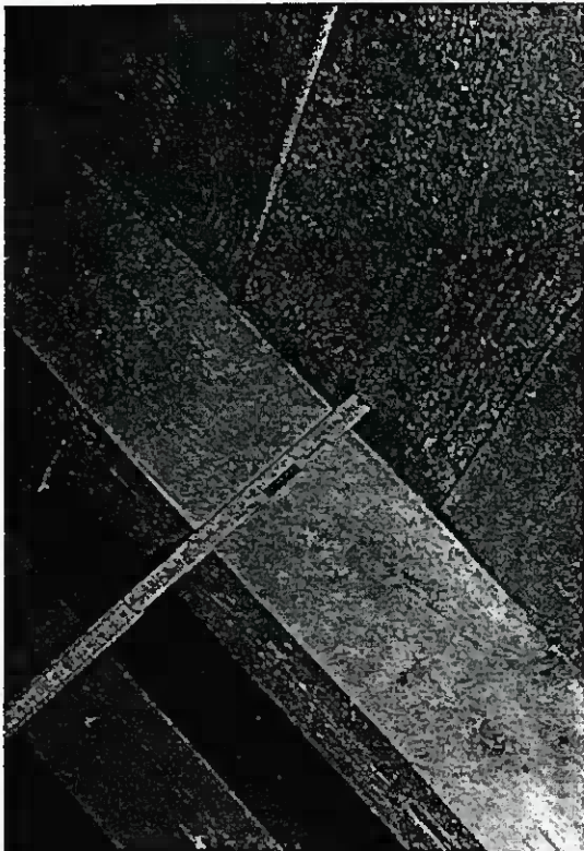
Oben: Bild 3: Starker Schimmelpilzbefall an der Unterseite der Dachschalung
